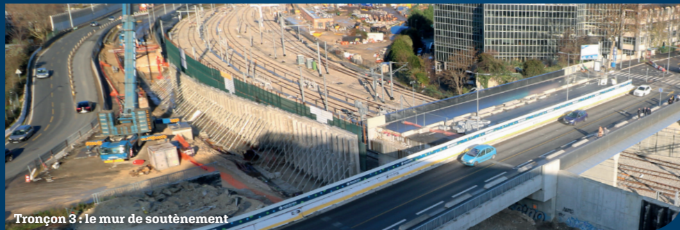
Tronçon 3: le mur de soutènement
