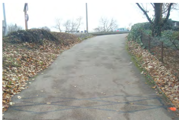
Figure 15 : compteur implanté sur le trottoir Sud de la RD910 Pont de Sèvres
