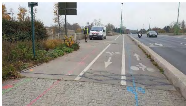
Figure 13 : compteur implanté sur le trottoir Nord de la RD3 Pont de Suresnes
