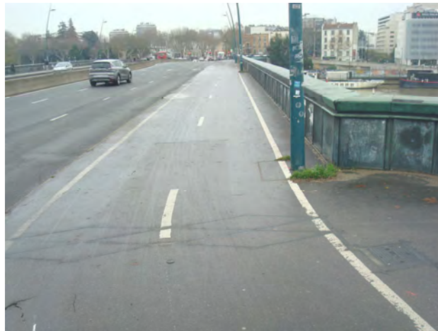
Figure 14 : compteur implanté sur le trottoir Sud de la RD907 Pont de Saint-Cloud
