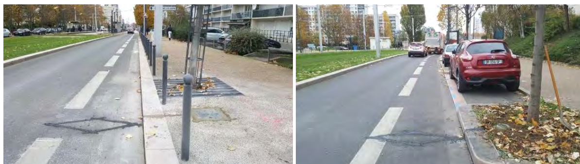
Figure 11 : compteurs implantés sur la RD986 à Villeneuve-la-Garenne côté Nord (à gauche) et côté Sud (à droite)
