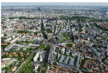
Réaménagement de la RD 920 entre Bourg-La-Reine (CD92), Cachan, Arcueil (CD94) et Paris
