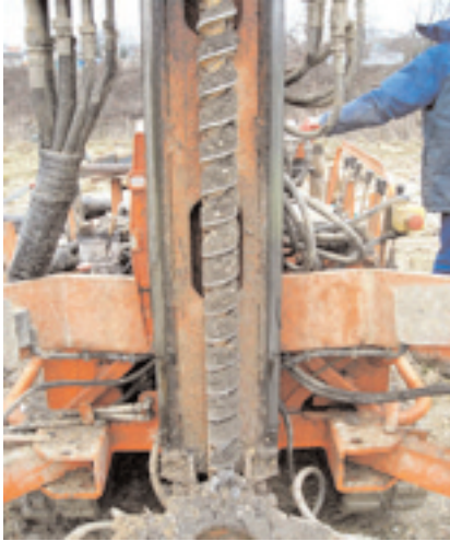
Figure 1 : Recherche de pollution de sol Aménagement des berges de Seine à Gennevilliers (source : Direction de l'Eau – CG92)
