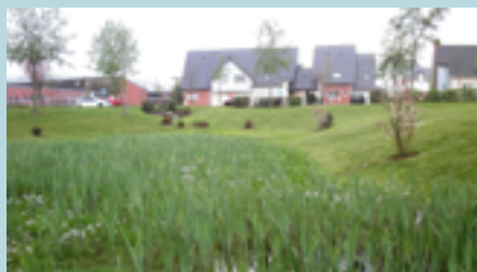
Bassin d'infiltration à Bois-Guillaume (76)
