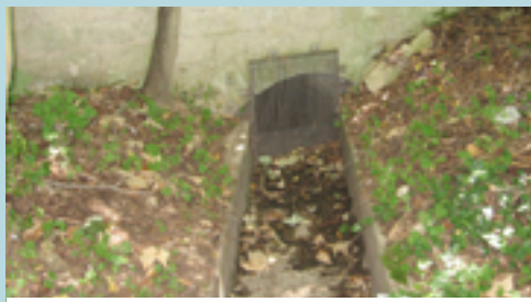
Grille protectrice, ru de Vaucresson
