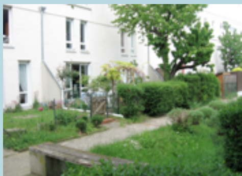
Gouttière déconnectée dans un lotissement à Antony
