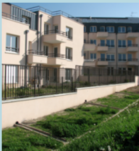
Gouttières déconnectées à Nanterre
