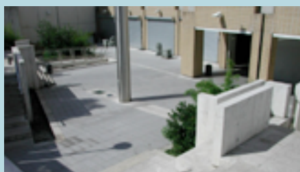
Place inondable infiltrante à Saint-Denis (93)
