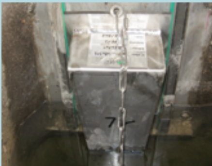
Régulateur à effet siphon avec chaîne d'extraction
