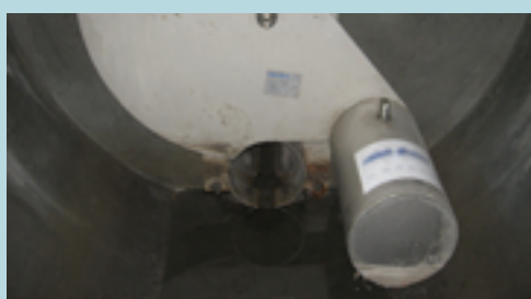
Régulateur de débit à flotteur
