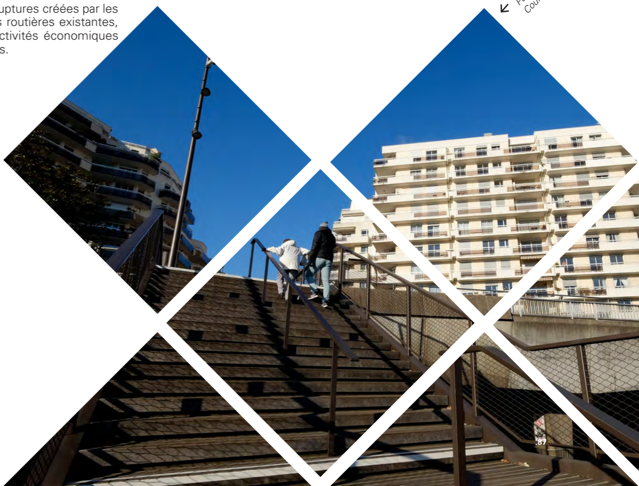
Passerelle de Courbevoie
