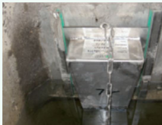
Régulateur accessible par une chaînette d'extraction depuis un regard dégagé et sécurisé
