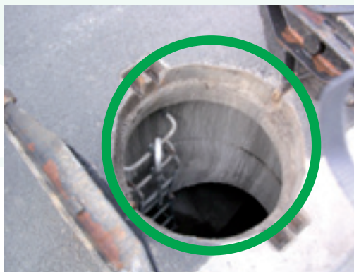
Accès dégagé et sécurisé
