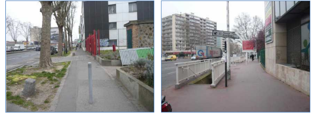
Figure 178 : Trottoir séparé de la chaussée par une bande verte et du stationnement à gauche et un trottoir en enrobé rouge à Montrouge à droite
