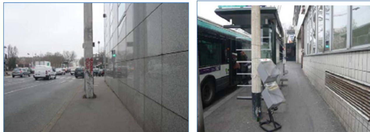
Figure 177 : Trottoir non PMR à gauche et trottoir rétréci par la présence de mobilier urbain à droite
