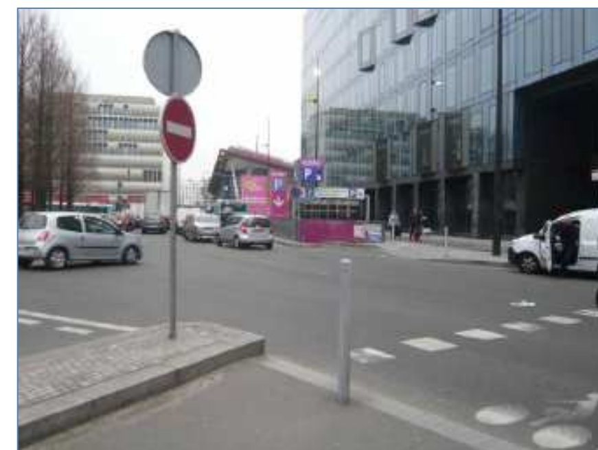
Entrée du parking souterrain de la Vache Noire
