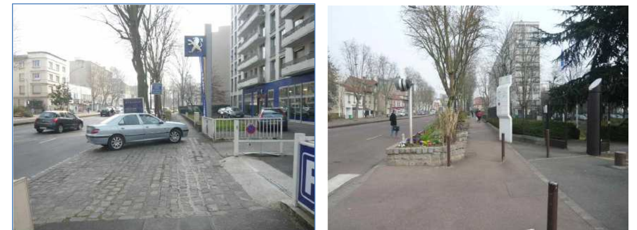
Figure 180 : Entrée charretière différenciée par un pavage à gauche et délimitée par des potelets à droite
