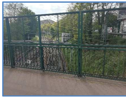
Figure 105 : Voie ferrée et talus végétalisés (Egis 2019)
